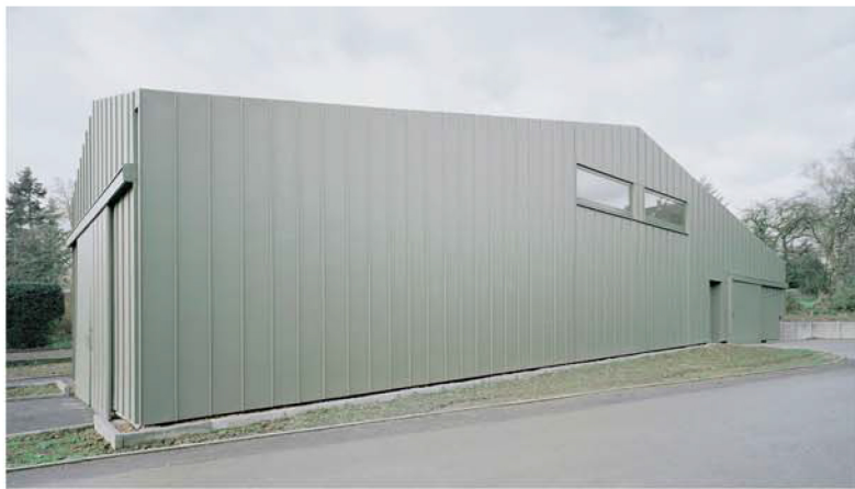
Graugrünes Titanzink als (wartungsfreie) Verkleidung © Brigida González
