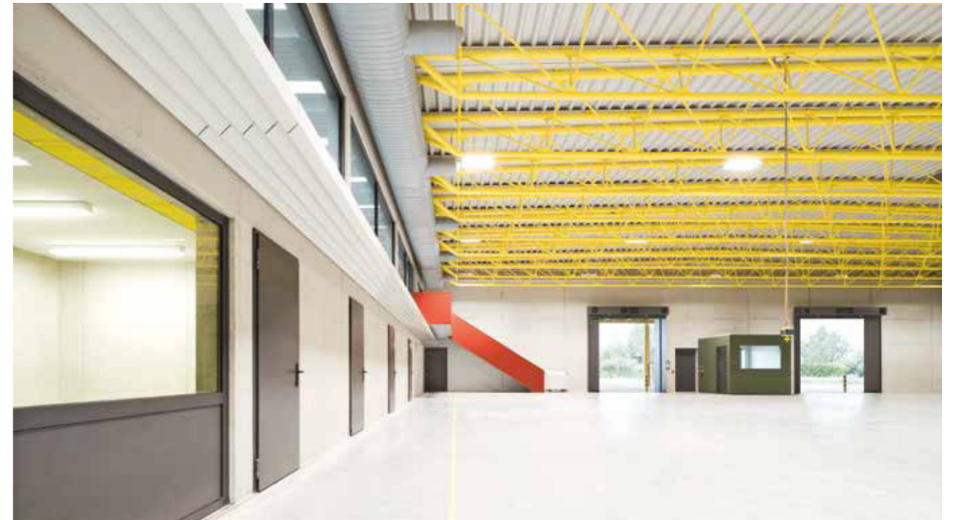
Innenraum mit filigraner Tragstruktur und geschickt platzierten Oberlichtschlitzen – der Neubau Halle 01 Niederstetten.
