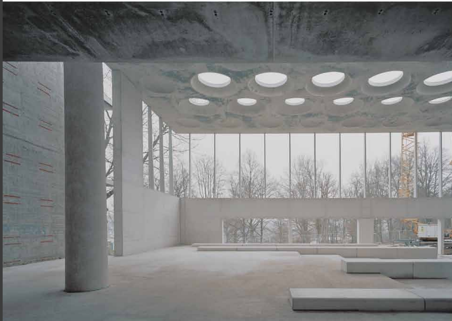
에른빌그 포럼의 내부 모습. 천장은 반구형 모양의 중공슬래브로 마감되어 있으며, 원형 기둥이 공간을 지지하고 있다.
