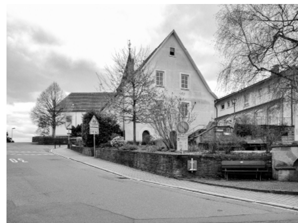
Die Ortsmitte vor der Umgestaltung. The town centre before the redesign.
