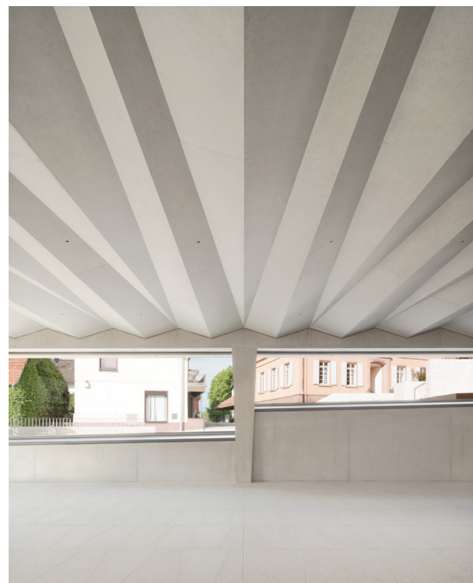
Die Schalung für das Betonfaltwerk wurde mit größter Präzision von einem Schreiner gefertigt. The formwork for the concrete folds was manufactured with a high degree of precision by a carpenter.
