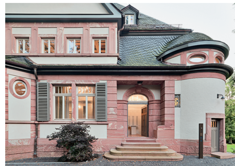
Der repräsentative Haupteingang in neuem Glanz • The prestigious main entrance shines in new splendour
