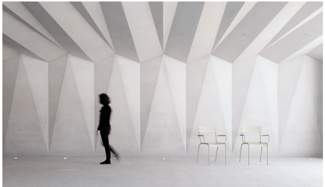
| Innenansicht Sichtbetonfaltwerk
