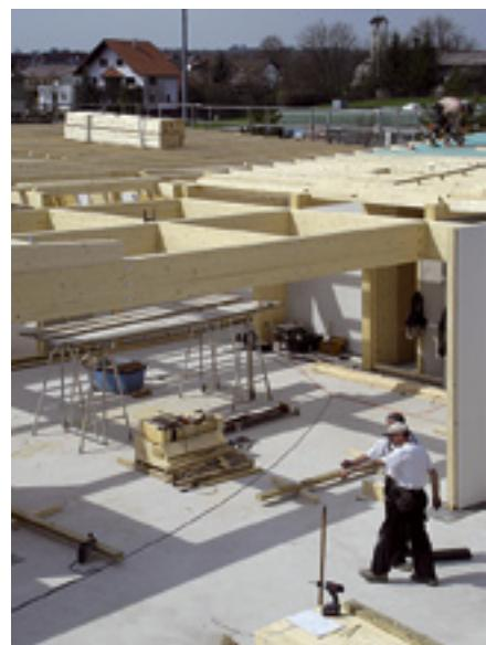
Liimapuurakenteet toimitettiin työmaalle valmiiksi työstettyinä, mikä takasi nopean asennusajan.
